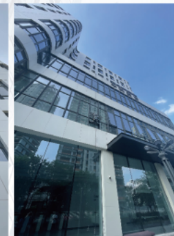
Podium curtain wall
